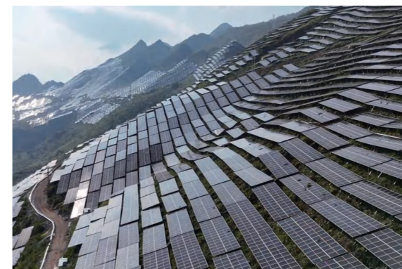
关岭百万千瓦级光伏基地
