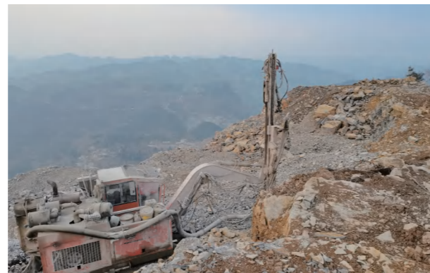
老包山地质灾害治理项目施工
